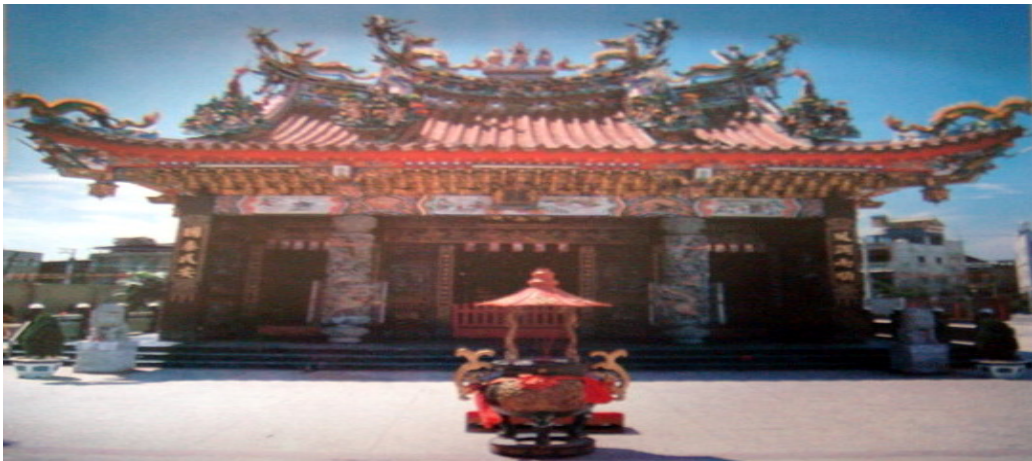
(福德伺全貌外觀，於民國七十六年完成建設。資料來源：由廟宇所提供-98.01.05)
