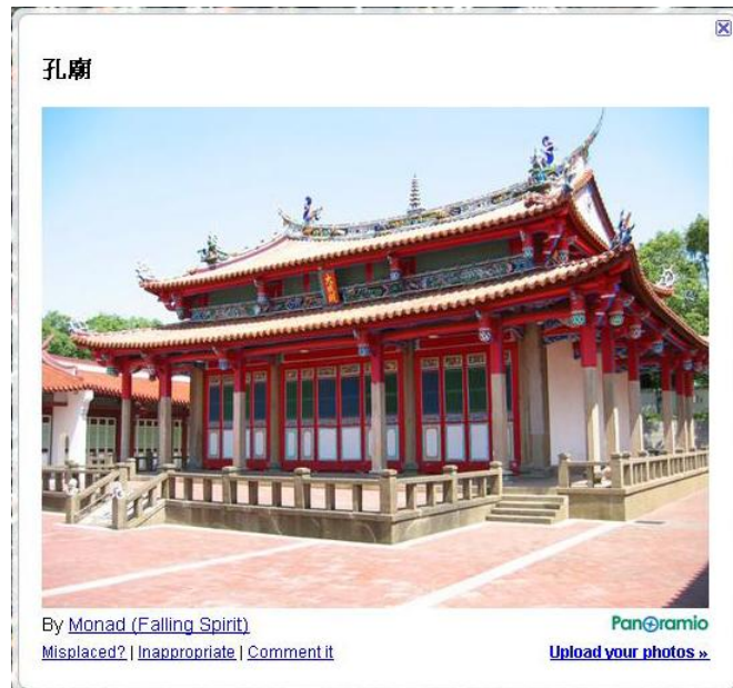
【圖 2-1-6】 新竹孔廟維修前
